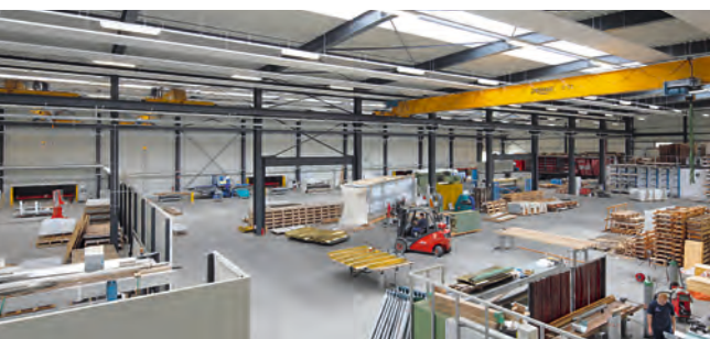
Neben einem Verwaltungsgebäude entstanden auf 4.400 m 2 Lager- und Fertigungsflächen. Am Standort Chemnitz werden Metallfassadenelemente hergestellt.
