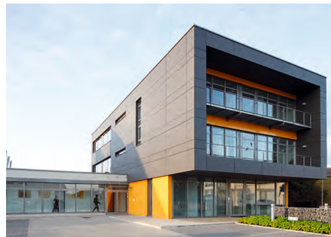
Die Schleuse zwischen der Produktion und der Verwaltung. Graphitspuren in dem Verwaltungsgebäude sind seit dem Umzug in den Firmenneubau Vergangenheit.
